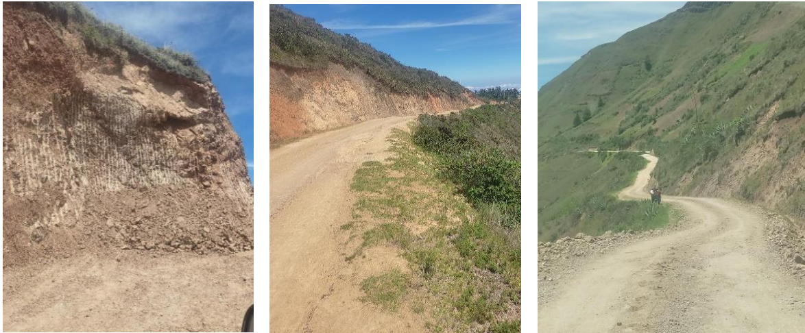
Nota: Registro fotográfico del estado vial comunidad Pasaloma. Elaborado: Equipo consultor, 2024.
